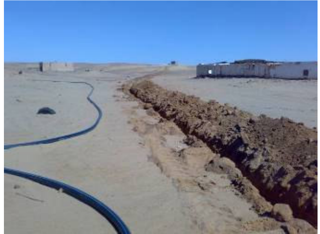
Fig. 12: Posa in opera della tubazione
