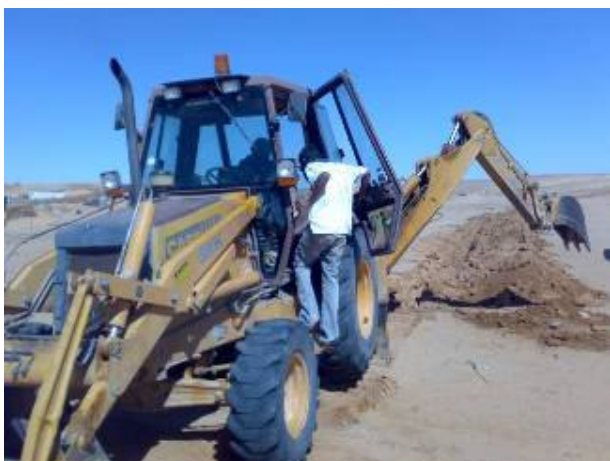
Fig. 9: Gli scavi per la condotta esterna.
