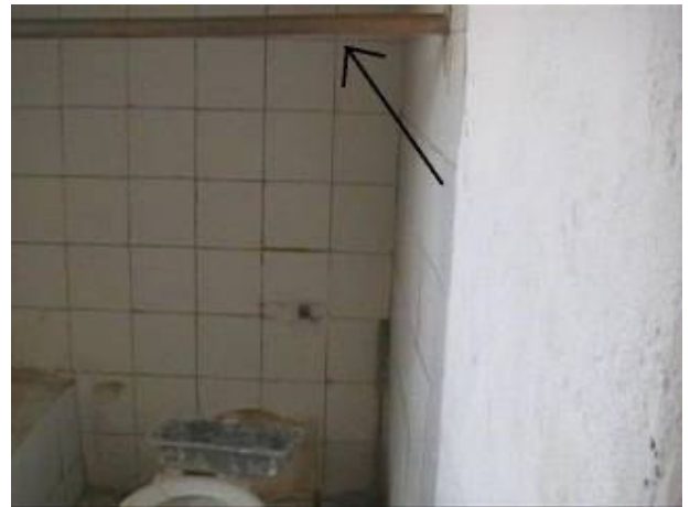
Fig. 20 : la stessa barra sul water.
