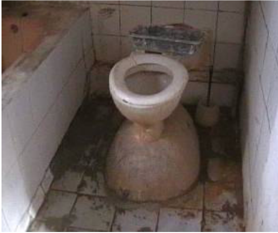
Fig. 17: Il water rialzato adattato per i disabili.
