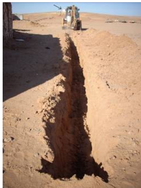
Fig. 8: La freccia nera dietro la ruspa indica il nuovo serbatoio dell'acqua.
