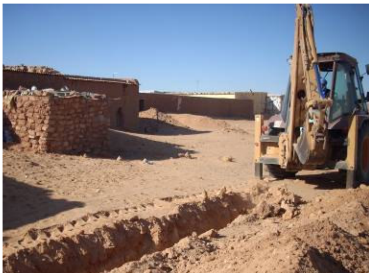
Fig. 7: Un momento dello scavo per l'interramento della rete idrica.
