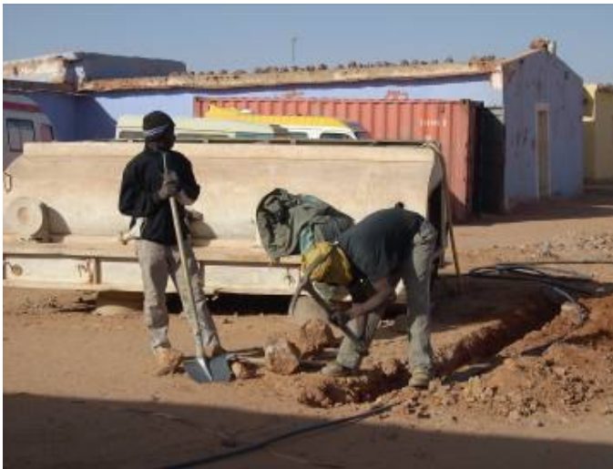
Fig. 13 e 14: Posa in opera della rete idrica interna.
