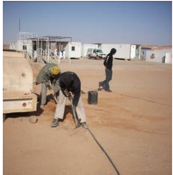
Fig. 13 e 14: Posa in opera della rete idrica interna.
