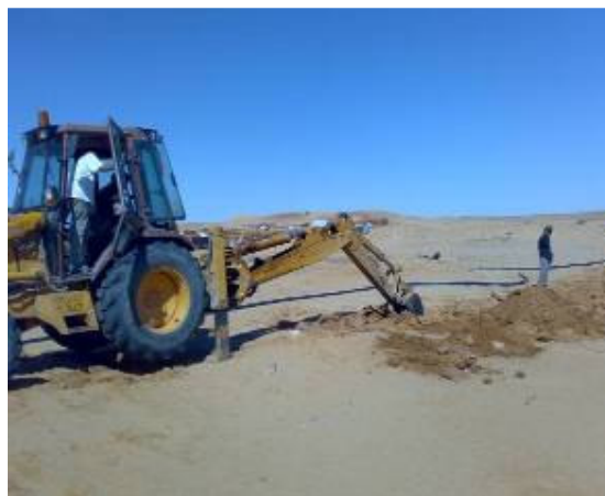
Fig. 10: Gli scavi per la condotta esterna.
