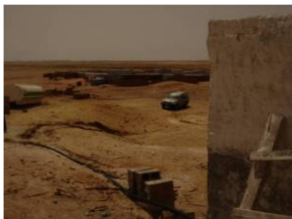
Fig.2 Il deposito attuale, in cemento, sulla destra e l'ospedale sullo sfondo.
