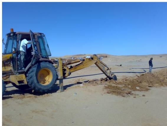
**fig. 16 Scavo della traccia**
