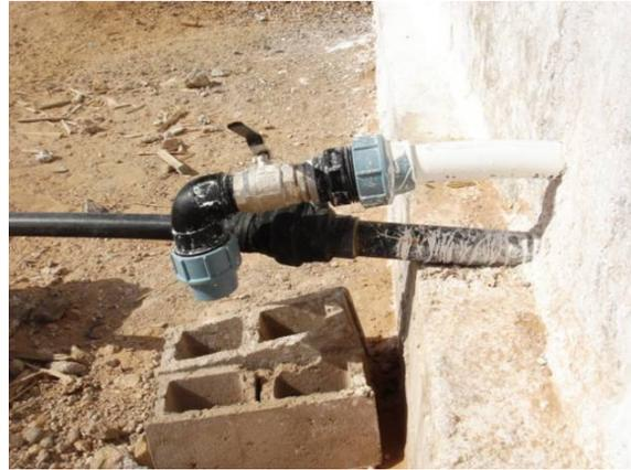
**fig. 22 Collegamento in uscita**
