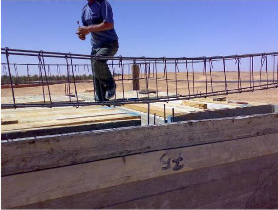
**fig. 11 Armatura delle pareti.**
