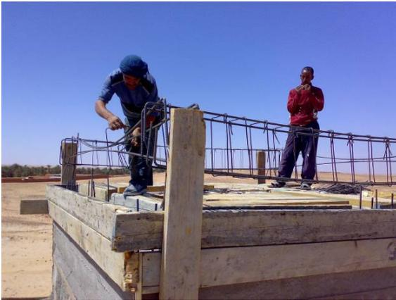
**fig. 13 Armatura del tetto**
