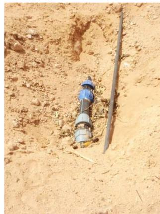
**fig. 24 Collegamento senza perdita.**
