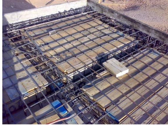
**fig. 12 Armatura del tetto**
