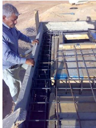
**fig. 14 Armatura del deposito**
