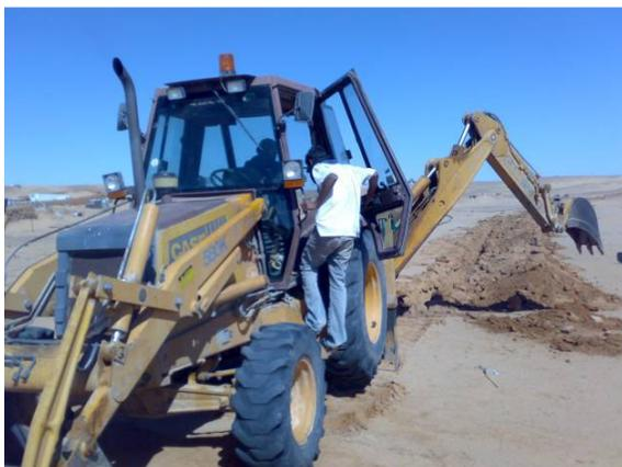
**fig. 15 Scavo della traccia**
