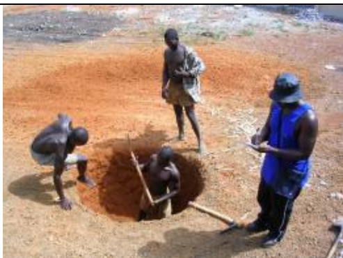
Scavo di un pozzo
