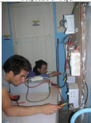
Riparazione impianto esistente
